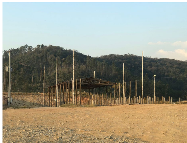
Foto 2: Situação atual das Estruturas no Canteiro operacional (17/08/2021)
