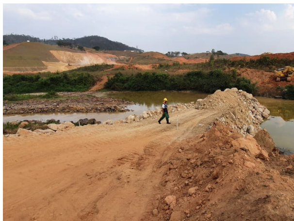
Foto 49: Construção ensecadeira J1 (13/10/2020)
