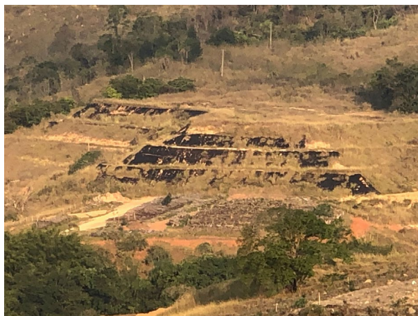
Foto 5: BF 3 Margem direita e pátio de madeira MD (18/08/2021)
