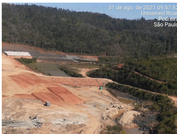
Foto 15: Área de apoio da obra e futura galeria de desvio (31/08/2021)
