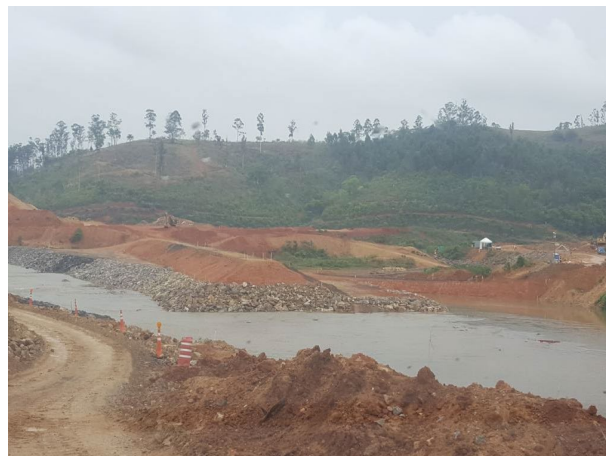
Foto 38: Retirada da ensecadeira M0 finalizada (15/10/2020)
