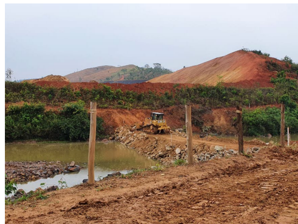
Foto 50: Construção ensecadeira J1 (15/10/2020)
