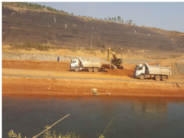
Foto 37: Retirada da ensecadeira M0 (07/10/2020)
