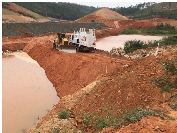
Foto 48: M1a em construção (09/10/2020)
