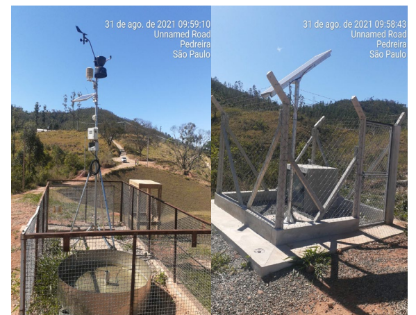
Foto 8: Estações de monitoramento (clima/sismógrafo) instaladas (31/08/2021)
