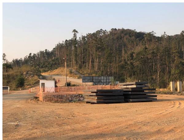
Foto 4: Situação atual das Estruturas no Canteiro operacional (17/08/2021)
