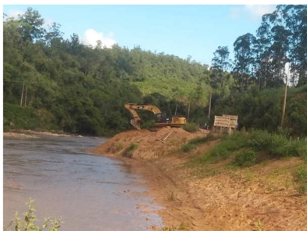
Foto 39: Construção da ensecadeira J0 (29/01/2020)
