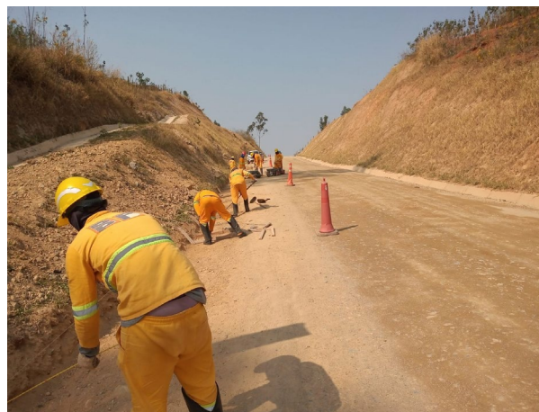
Foto 18: Manutenção das canaletas – acesso MD03 (25/08/2021)
