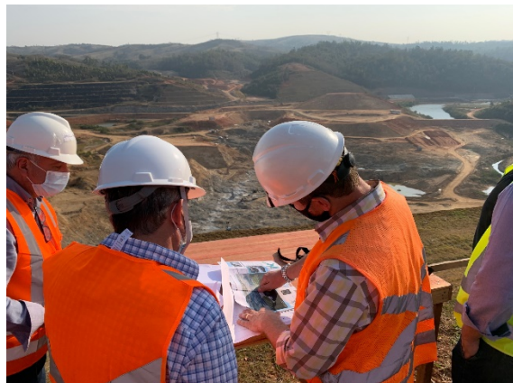
Foto 59 Vistoria na obra com os representantes do Comitê. 11/08/2021
