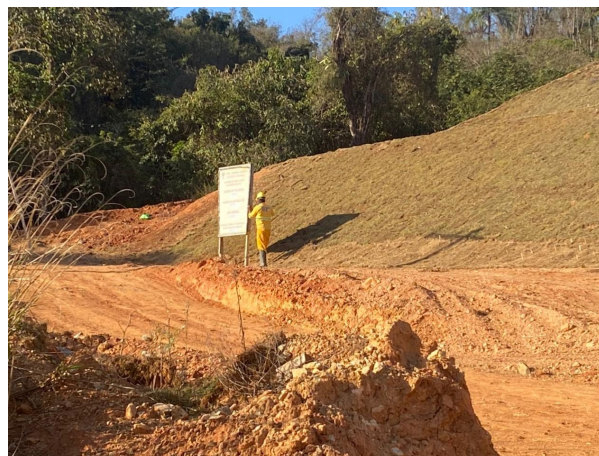
Foto 6: Instalação da placa da ASV – escada hidráulica (20/08/2021)
