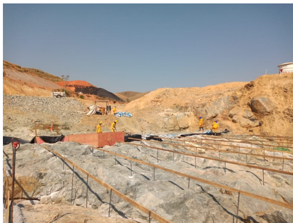
Foto 17: Área da galeria de desvio do Rio Jaguari (24/08/2021)
