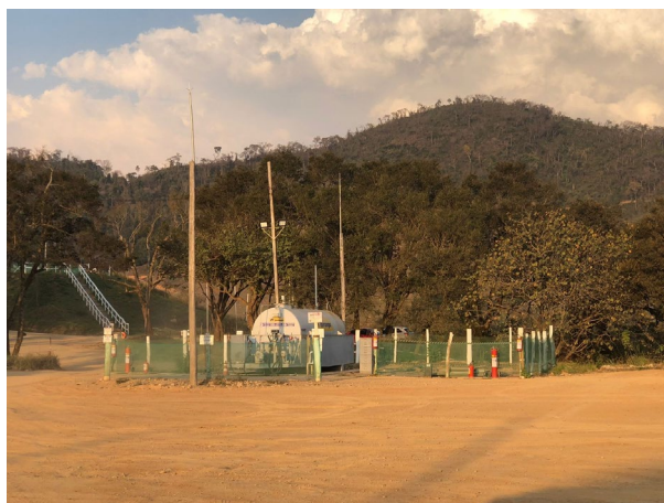
Foto 3: Situação atual das Estruturas no Canteiro operacional (17/08/2021)
