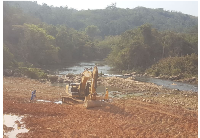
Foto 42: Retirada da ensecadeira J0 finalizada (08/09/2020)
