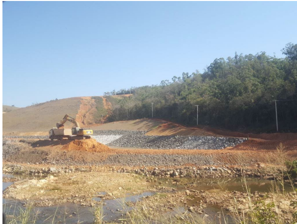
Foto 41: Retirada da ensecadeira J0 (08/09/2020)
