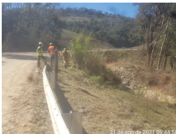
Foto 21: Acesso MD03 estacas 5 até 30 – Roçamento da vegetação (31/08/2021)
