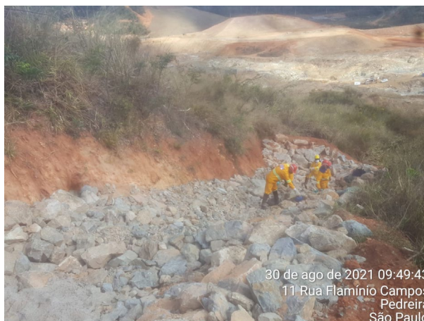
Foto 19: Manutenção no sistema de drenagem provisória no bota espera – margem direita (30/08/2021)
