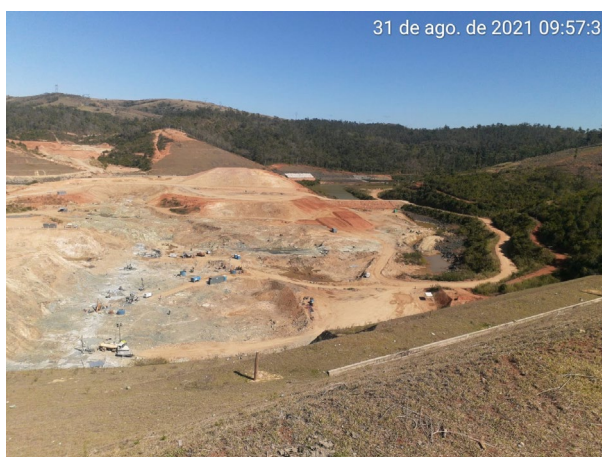
Foto 11: vista superior: tratamento de fundação (31/08/2021)
