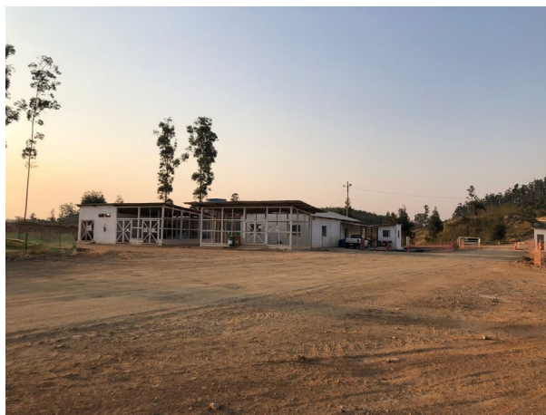
Foto 1: Situação atual das Estruturas no Canteiro operacional (17/08/2021)
