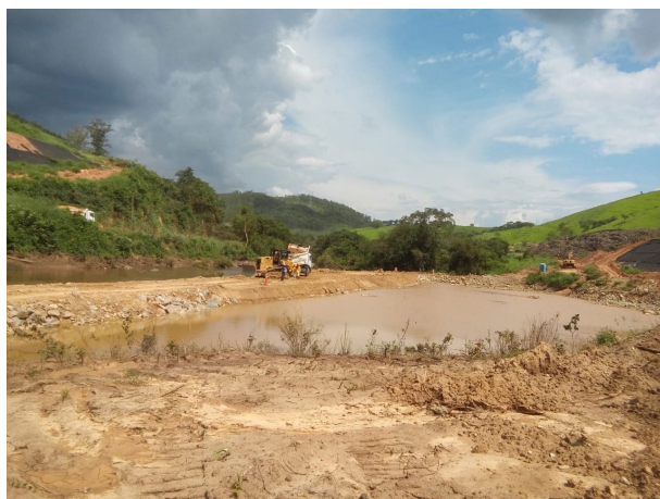
Foto 35: Construção da ensecadeira M0 (31/01/2020)
