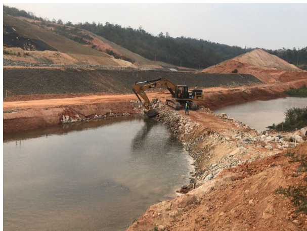
Foto 47: M1 em construção (08/10/2020)
