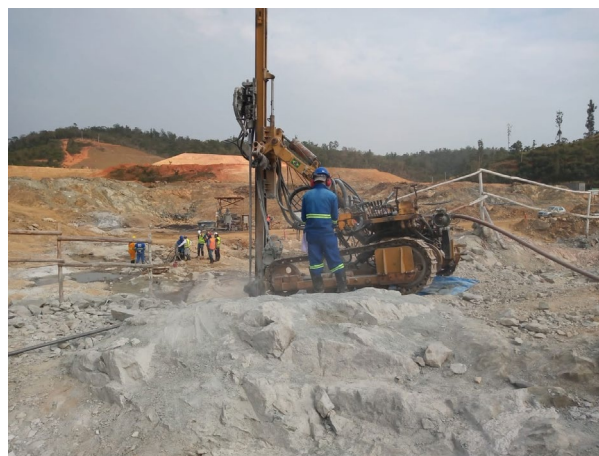
Foto 20: Injeção de cimento (tratamento de fundação) (27/08/2021)
